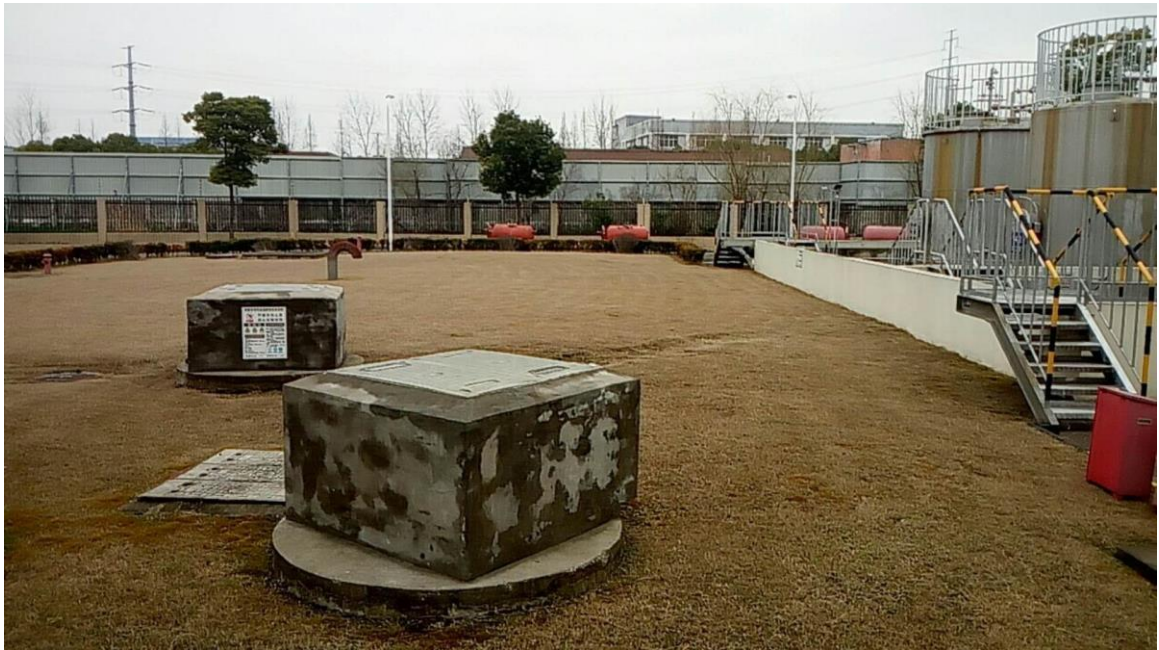
附图：事故阀及雨水阀阀井
