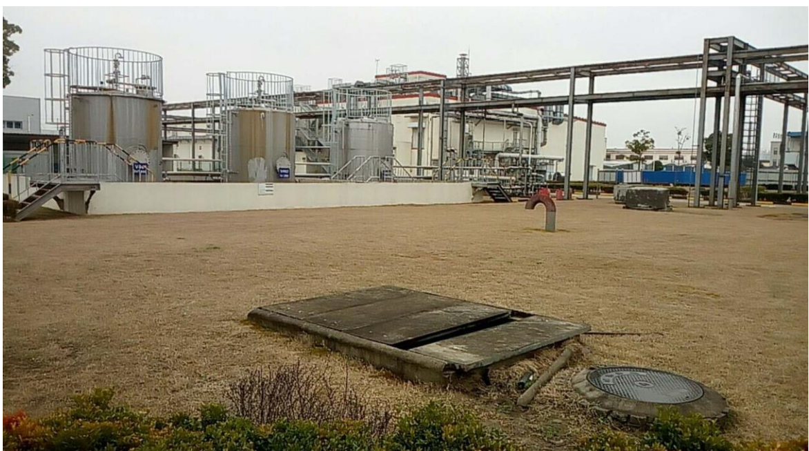
附图：罐区及事故池局部
