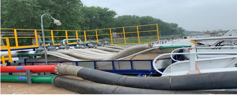
2、码头运行部通过工艺管线进行油品和液体化工产品的输送，具有输转点多、工作面广、管线长、紧临长江布置等特点。输送环节如果工艺管线发生泄漏，泄漏的油品极易流入长江，造成水体污染事故等。
