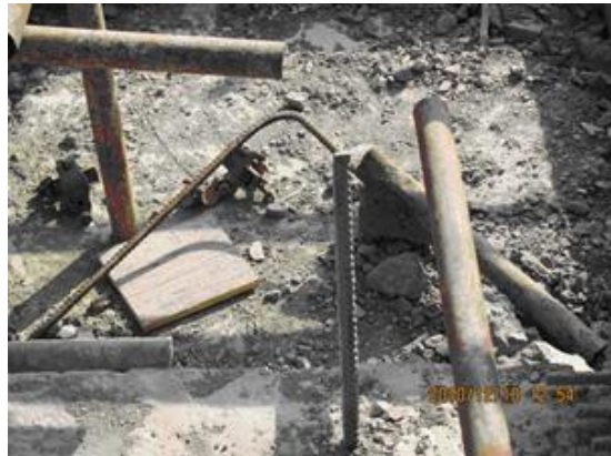
15-2 平台锚固点的钢筋
