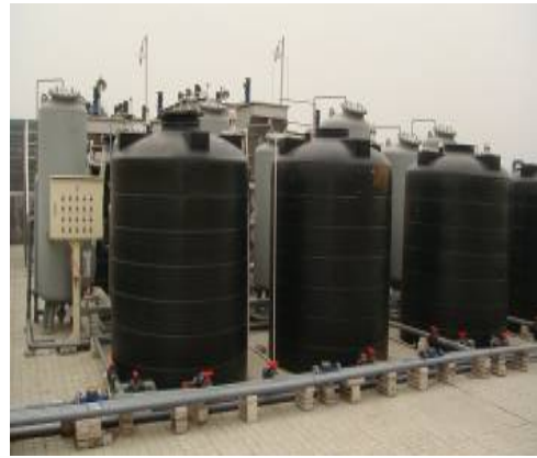
图七：废水储水罐循环回收系统
