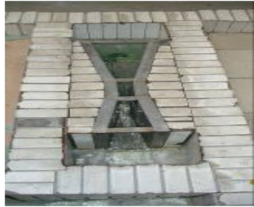
图六：污水排放水
